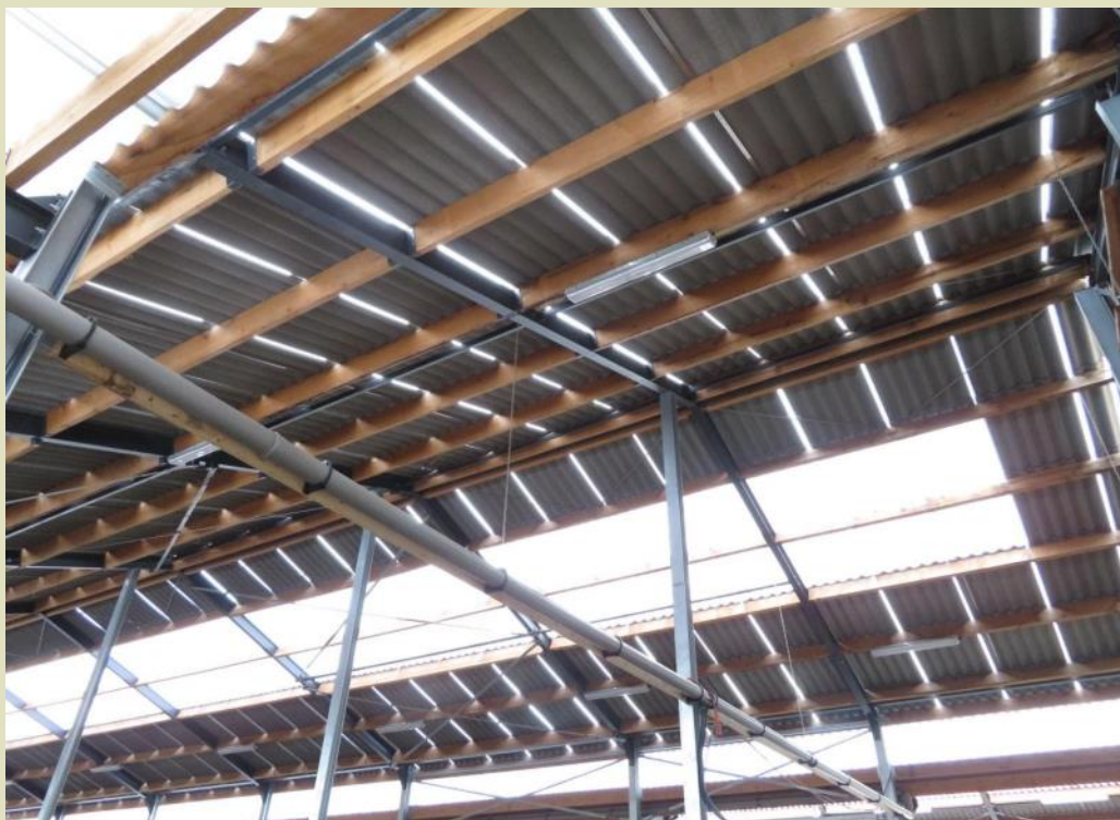
Nieuwe stal bij Gerard Noordman: tussen de dakbedekking is een smalle strook opengelaten. Mogelijk dat de temperatuur daardoor niet te hoog oploopt. (Foto Peter Kerkhofs)
