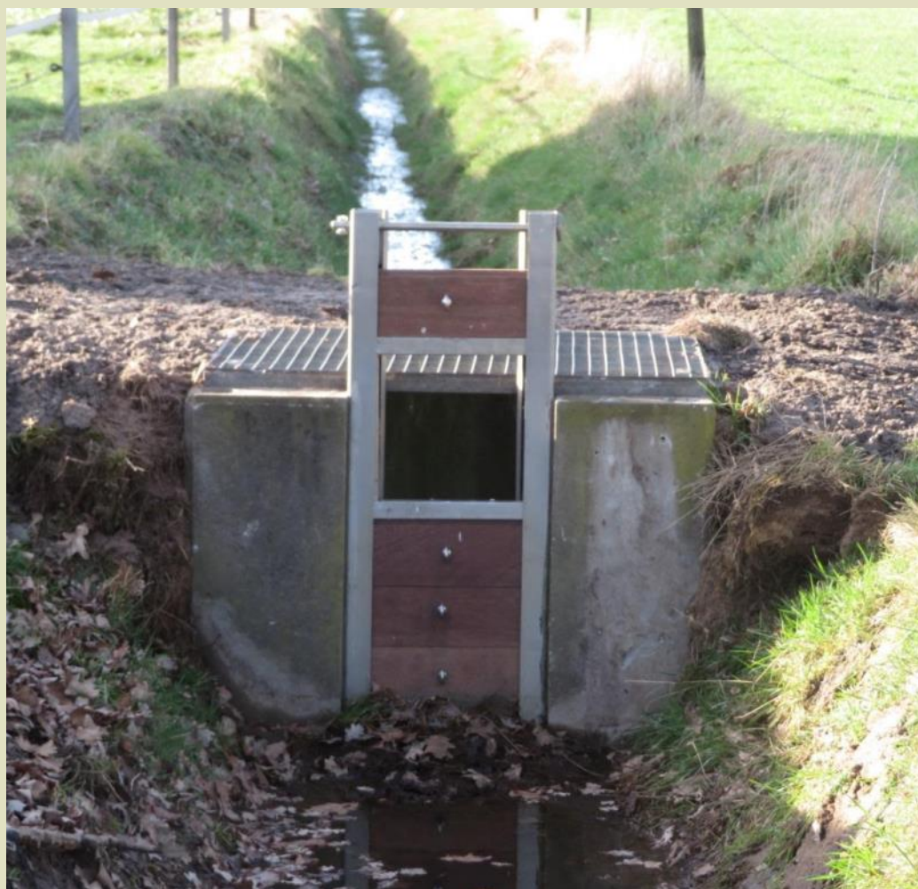
De eerst geplaatst stuw aan de Burgemeester Vogelslaan. Er volgen er nog twee. Foto: Peter Kerkhofs
