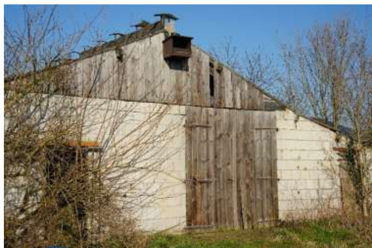
Torenvalkkast aan schuur
